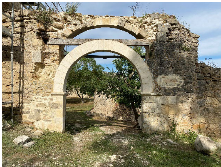
Figura 7. Arco de entrada terminado Fuente: MUCRPA
